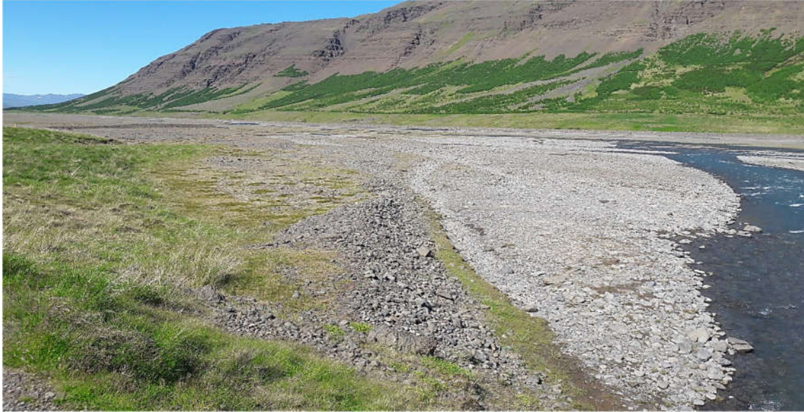
Mynd 50: BAN-41. Horft yfir svæðið frá brúnni yfir Egilsá.
